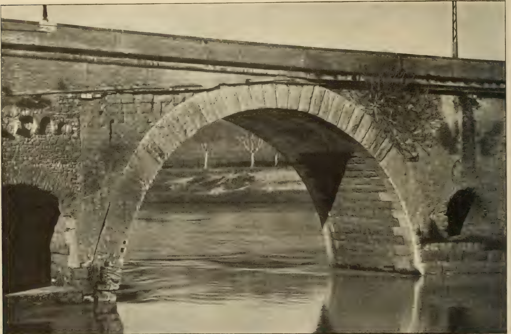
Abbildung 10. Der erste Strombogen von Süden gezählt, Ansicht von Osten.
